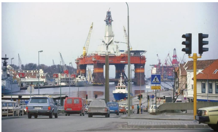
Stavanger og Vågen 1987; nye tider med dåp av West Vision og offshorearbeid på Rosenberg. Foto Stavanger Aftenblad
